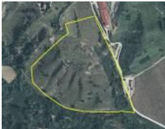
prima dello sbancamento
